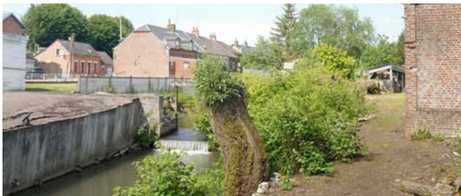
La continuité écologique est rompue par un seuil sur ce cours d'eau canalisé - Noirrieu à Esquéhéries (02).
