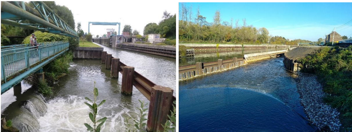
Figure 36 Aménagement de l'ouvrage à la confluence Selle-Escaut en 2021 par VNF (A gauche avant, à droite après restauration)
