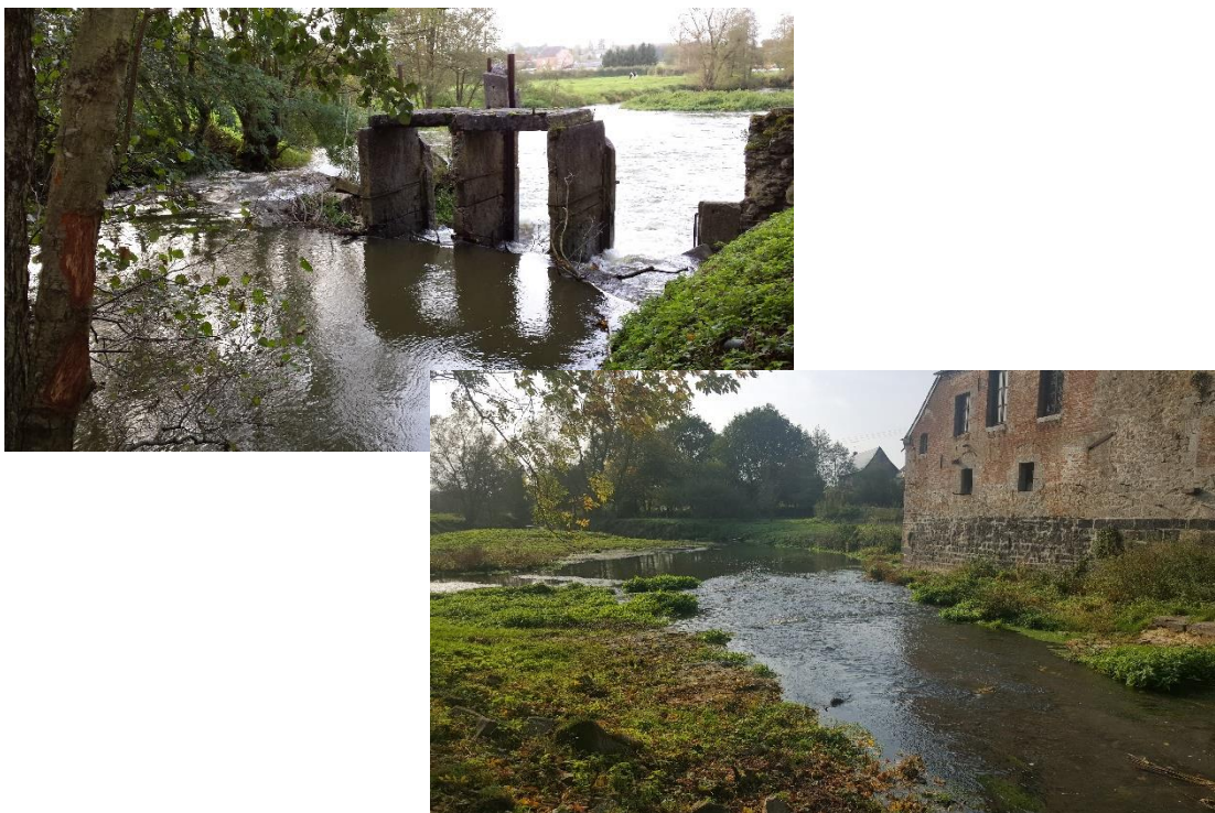
Figure 28 Arasement du seuil de Semeries sur l'Helpe majeure (SMAECEA)
