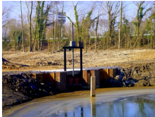
Figure 21 Ouvrage hydraulique de l'annexe alluviale de Marpent sur la Sambre
