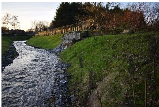
Figure 35 Site d'intervention après travaux
