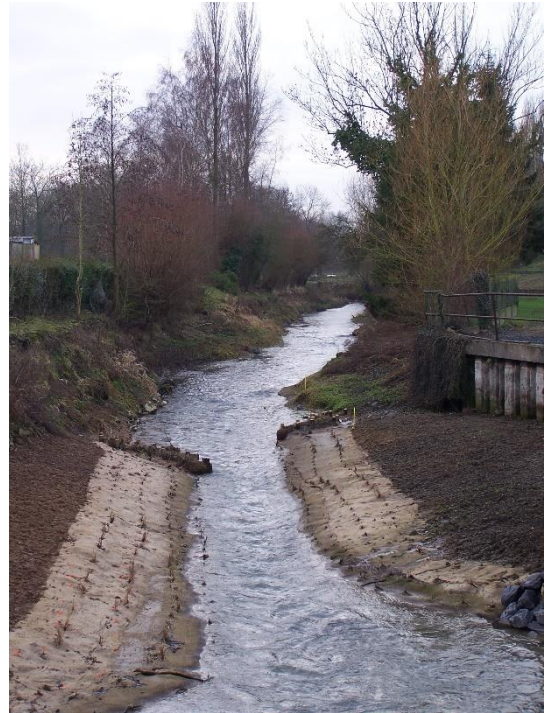
Figure 30 Dérasement du seuil du pont fourneau sur la Selle (SMBS)
