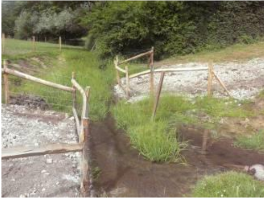
Figure 9: Descente aménagée réalisée en 2012 sur le ruisseau de la Belleuse à Felleries
