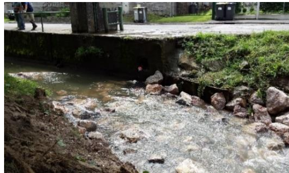
Figure 37: Mise en place d'une rampe en enrochement
