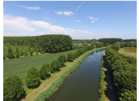
Figure 19: Déconnexion latérale de la Scarpe canalisée avec ses annexes alluviales et son lit majeur.
