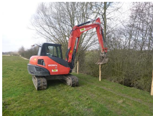
Figure 4: Pose de piquets en châtaignier
