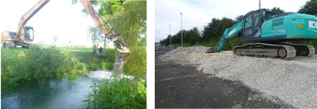
Figure 13 Recharge granulométrique sur la rivière Selle
