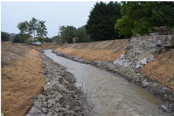
Figure 26 Effacement d'un système de vannage et restauration hydro-morphologique de la Solre à Obrechies en 2019
