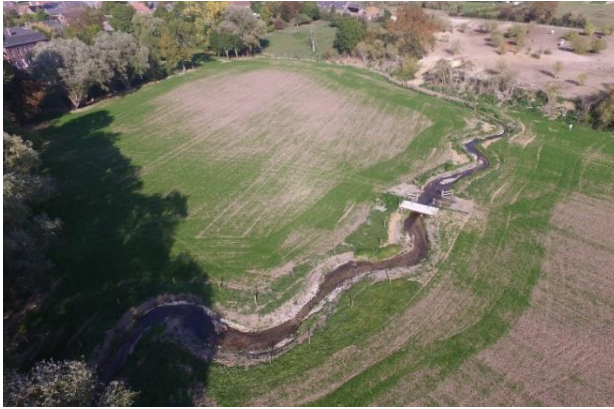
Figure 33 Site d'intervention après travaux
