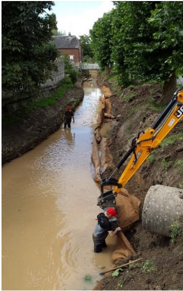
Figure 38 Mise en place de boudins d'hélophytes
