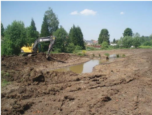
Figure 20 Terrassement de l'annexe alluviale de Catillon-sur-Sambre sur la Sambre
