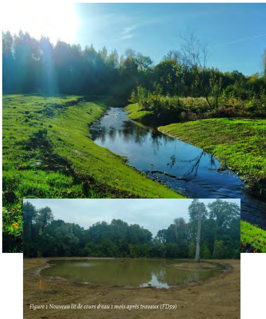
Figure 1 Nouveau lit de cours d'eau 1 mois après travaux (FD59)
