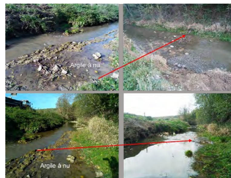
Figure 2: Vues vers l'aval : perte de substrat laissant l'argile à nue (à gauche) et après recharge (à droite) (FD59)
